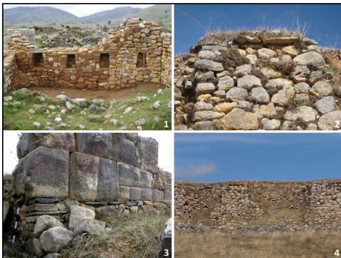
Figura 12. Principales indicadores arquitectónicos del aporte local. 1. Piedras canquil utilizadas como dinteles en los nichos de un recinto; 2. Detalle de los restos de la cornisa que remataba el paramento este del kushipata ; 3. Vista del aparejo “Mixto B” localizado en la UA43 y 4. El colapso por secciones en el muro este del kushipata denota la ausencia de sólidos amarres entre los paños construidos a través del sistema de chutas . Lámina elaborada por Castro (2017) basándose en las fotografías de Pino (2009) y Ordóñez (2007 y 2011).
