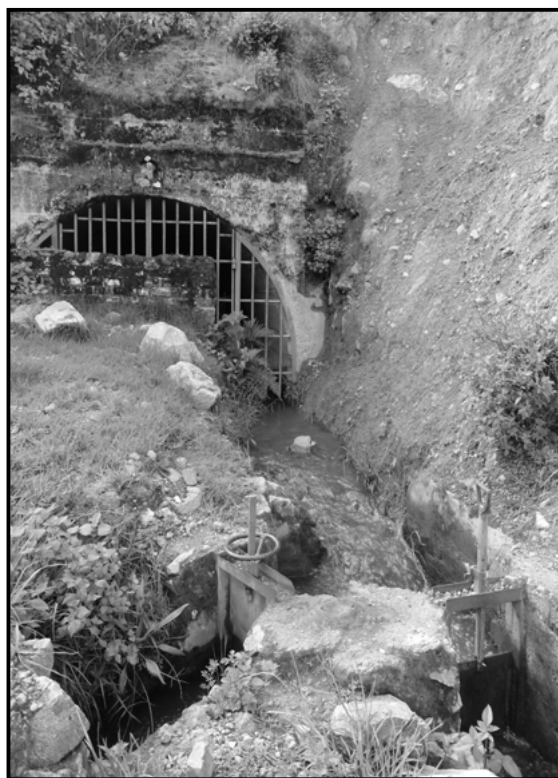
Figura 2. Una de las “ventana” (salidas de agua) de la comunidad de Huachupampa, desviando el agua hacia los canales de riego de la comunidad (Foto: L. Hommes, 2015).
