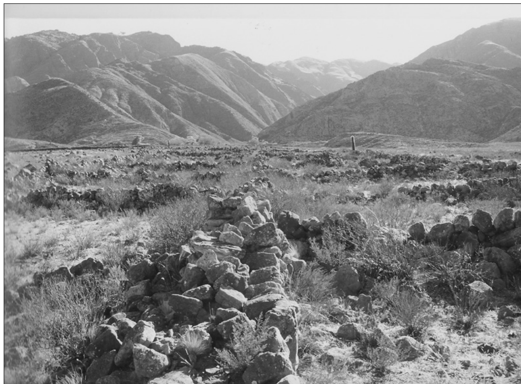
Figura 3. Perspectiva que muestra el muro interno longitudinal –que divide la estructura III de Urbina (Salta) en dos hileras– y a los muros transversales que forman los recintos.
