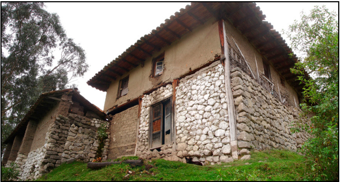
Figura 5. Vista posterior del edificio principal. Fuente propia.
