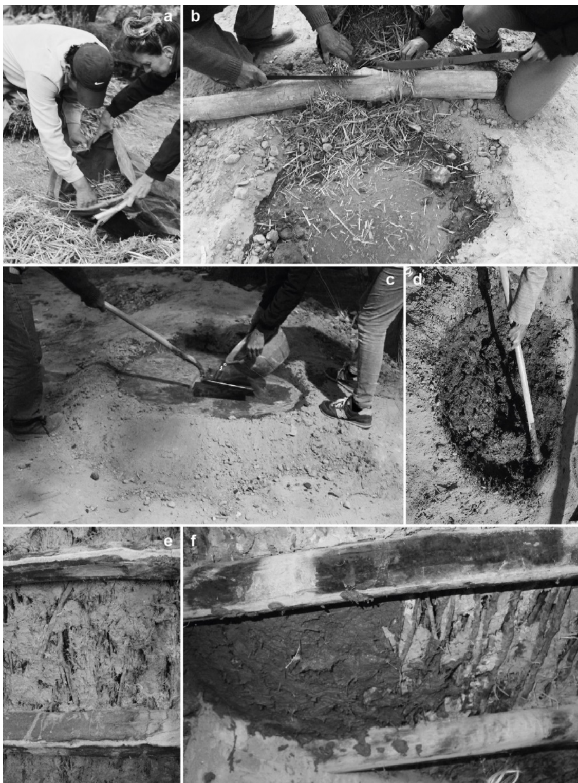
Figura 3. (a) Recolección de paja de cebada (b) Picado de la paja de cebada y colocación directa en el pastón (c) Lavado de herramientas al finalizar el día sobre el pastón de barro para que quede inundado hasta el otro día y reutilización de agua (d) Pastón con barro en estado plástico (e) y (f) Capas de tumbadillo en ejecución. Fuente: archivo de los autores.
