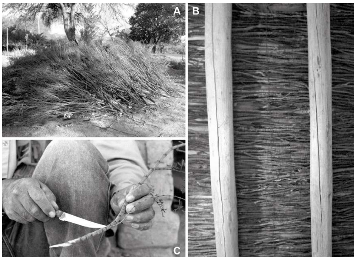
Figura 6. Acopio y acondicionamiento de la jarilla. (A) Acopio de las ramas de jarillas en la vivienda. (B) Techo con base de jarilla, (C) Detalle de corte de ramas secundarias para acondicionamiento y posterior colocación en el techo explicado por el constructor local Gustavo Escalante. Fuente: archivo de los autores.
