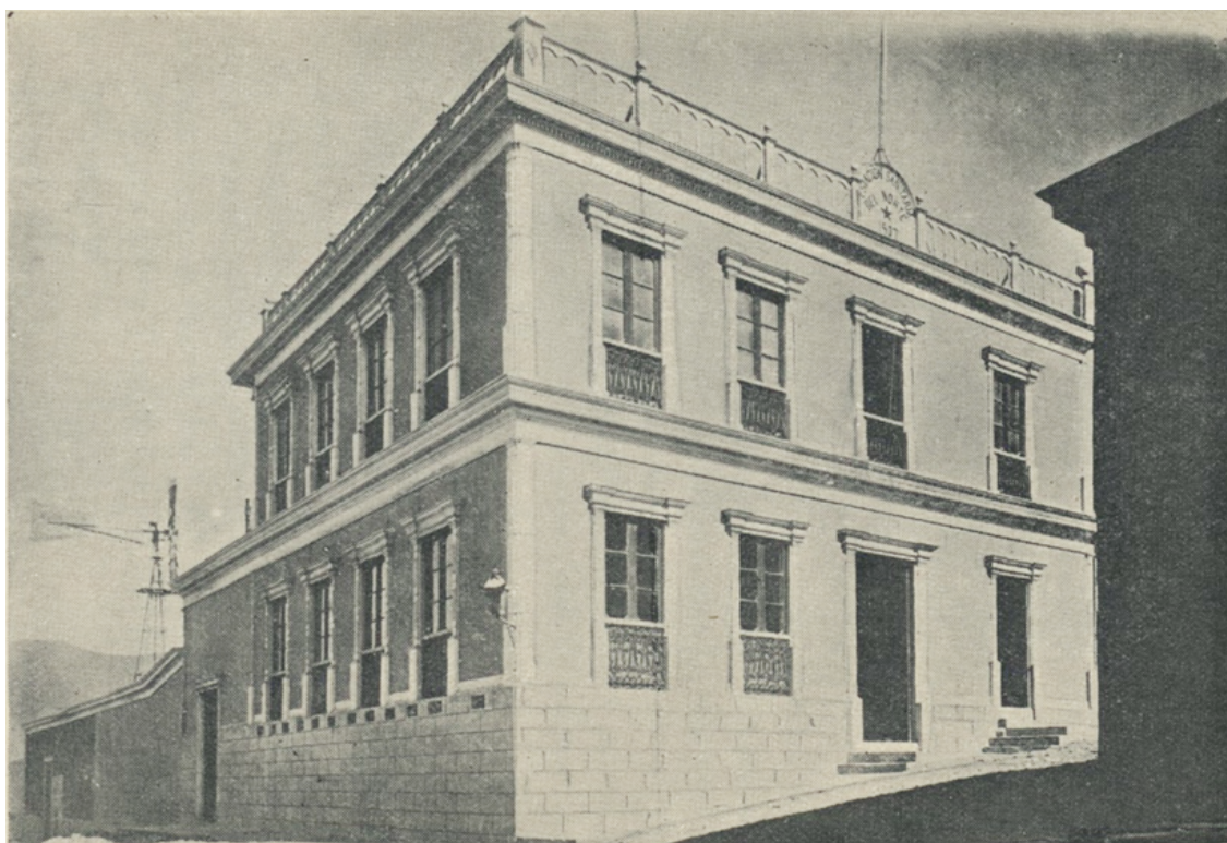
Figura 7. Oficinas de la Estación Sanitaria de Arica.
