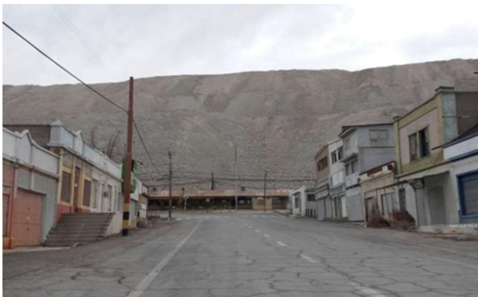
Figura 2. Avance del relave. Vista de los relaves avanzando sobre el campamento (Fuente: Foto de las autoras.)
